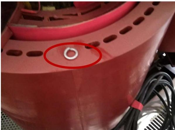
高压线圈发现金属垫圈
