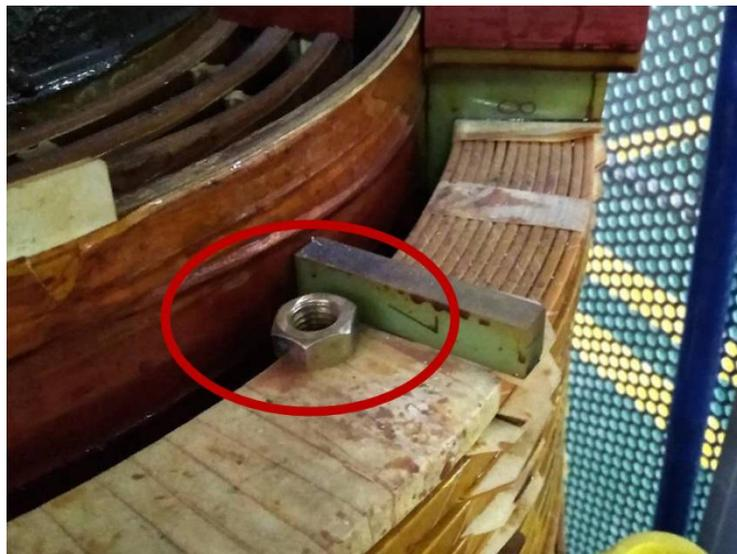
高压线圈端部发现的螺母
